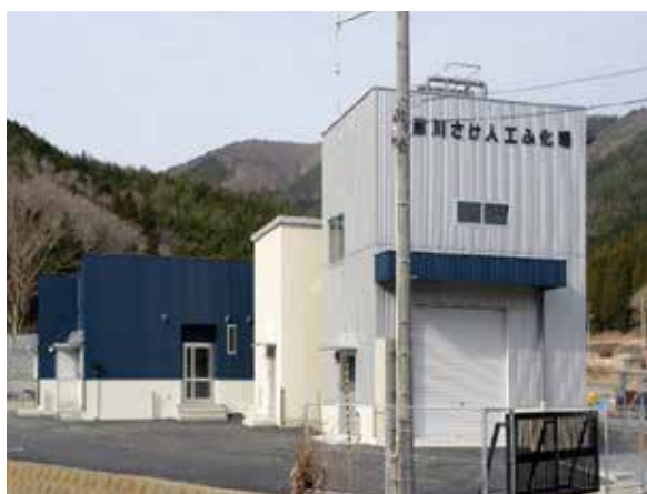
大原川さけ人工ふ化場
