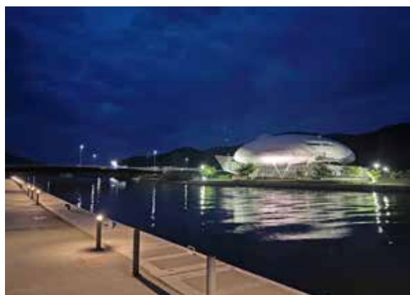
照明施設(中央地区)
