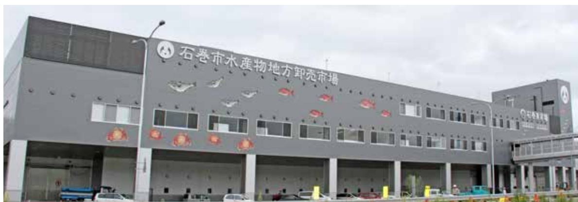
石巻市水産物地方卸売市場石巻売場管理棟
