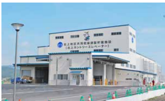
北上カントリーエレベーター
