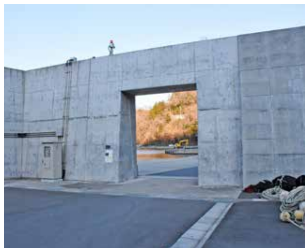
名振漁港2号陸閘
