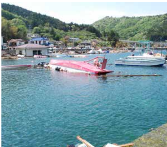
地震による地盤沈下で沈降した水浜分浜漁港の物揚げ場 (2011(平成23)年)
