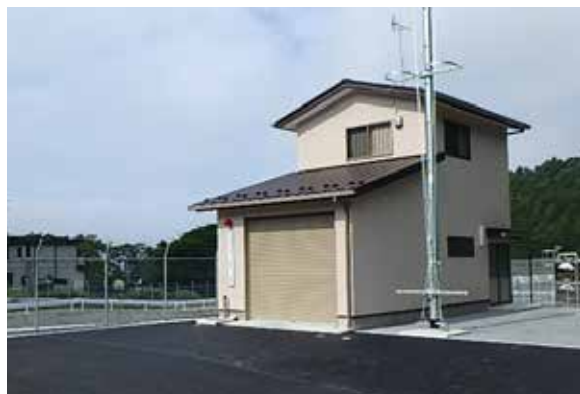
大原班ポンプ置場
