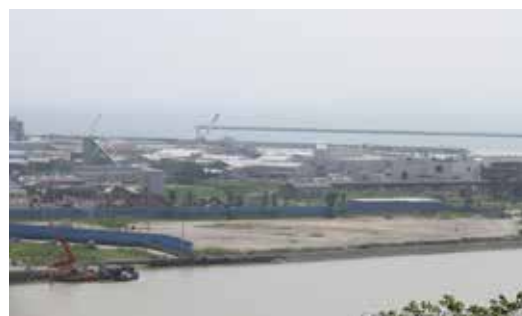
処理が完了し更地となった
