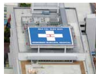
屋上ヘリポート
