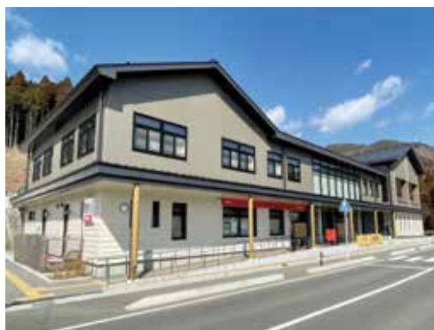
雄勝総合支所
