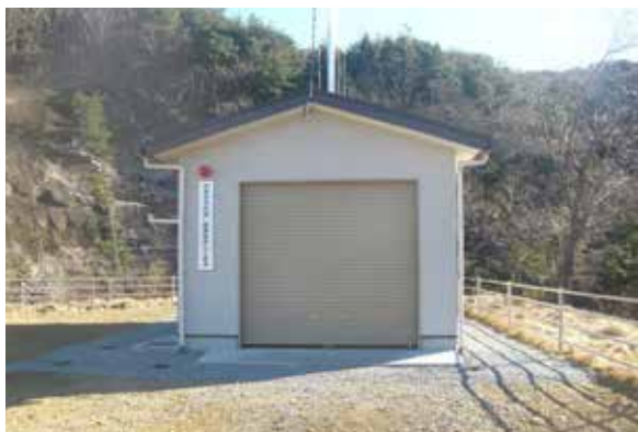
船越班ポンプ置場
