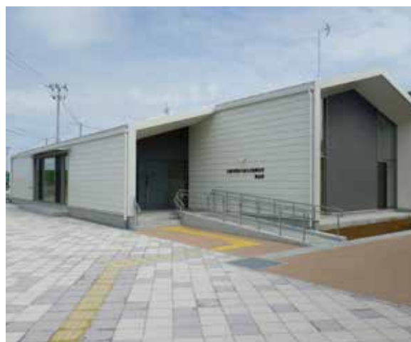
復興公営住宅内集会所
