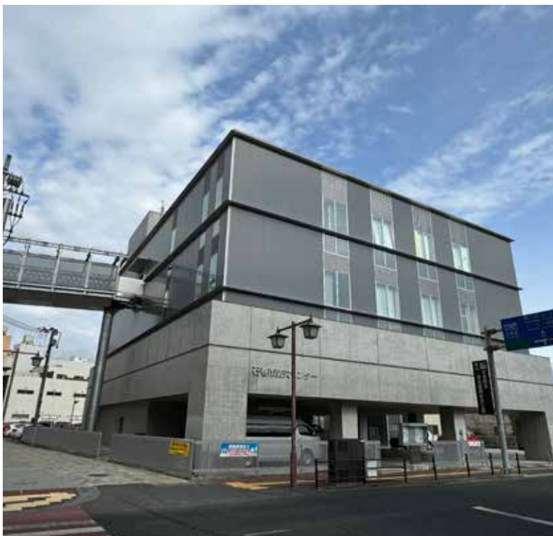
防災センター
