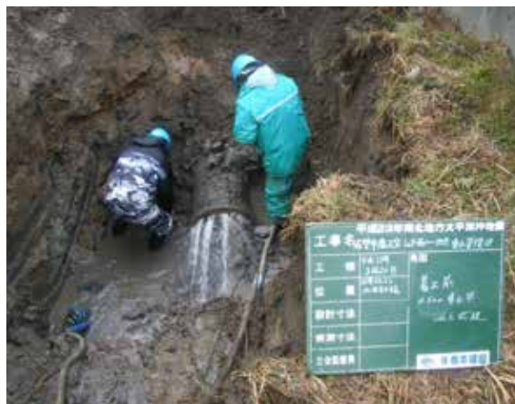
管路の復旧工事の様子 提供:石巻地方広域水道企業団
