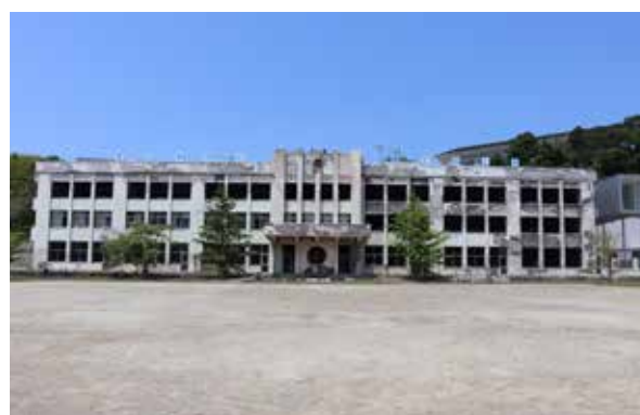
震災遺構門脇小学校
