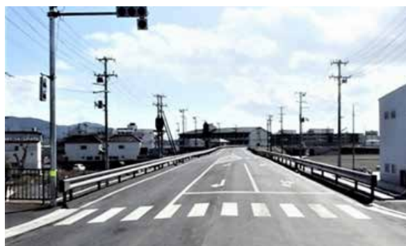
石巻地区・湊西より魚町方面（湊西区画整理地内）
