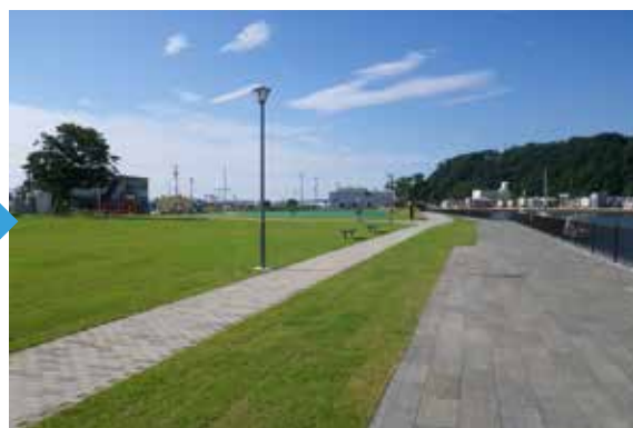
中瀬公園復旧後
