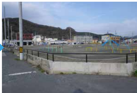
松並公園復旧後
