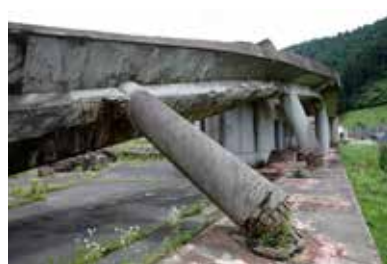
津波の威力でねじり倒された渡り廊下
