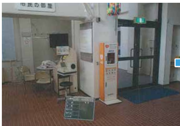
耐震補強工事前の牡鹿総合支所
