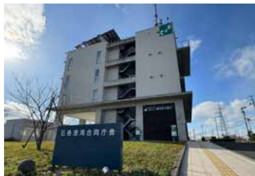
津波避難ビルとしても登録されている石巻港湾合同庁舎
