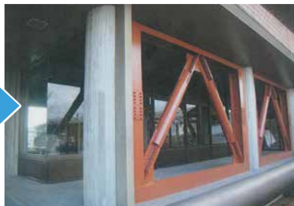
耐震補強工事後の河北総合支所
