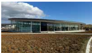
みやぎ東日本大震災津波伝承館
