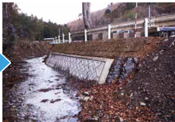
吉浜沢川復旧後
