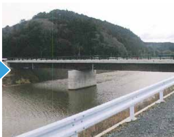
本地橋復旧後
