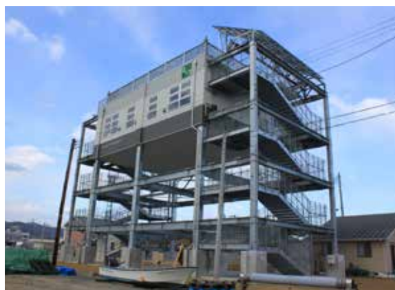
大宮町津波避難タワー
