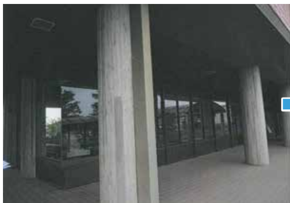
耐震補強工事前の河北総合支所
