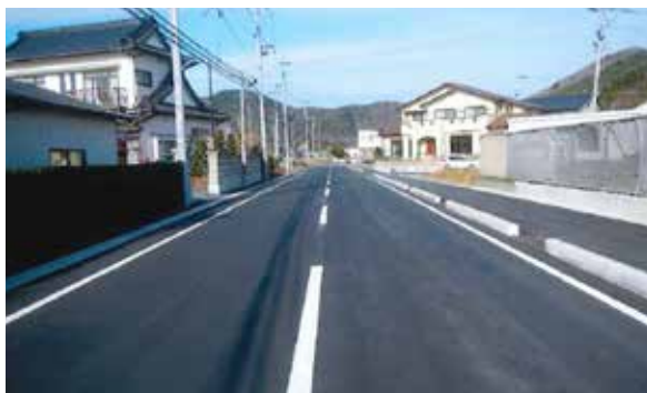
新渡波地区整備路線（石巻地区・渡波中学校東側）
