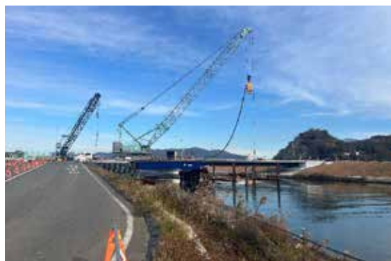
工事中の東中瀬橋（石巻地区・中瀬より八幡町方面）
