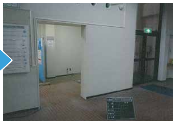
耐震補強工事後の牡鹿総合支所
