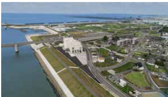
石巻中央排水ポンプ場(石巻地区・門脇町)
