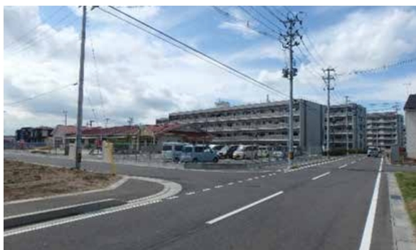
石巻地区・三ツ股より大街道西方面（下釜第一区画整理地内）
