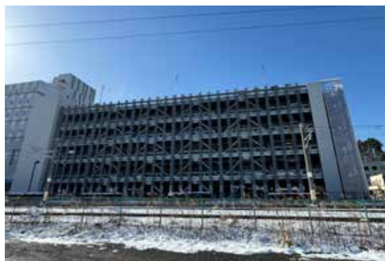
庁舎第2駐車場
