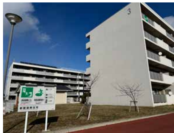
多くの集合住宅型復興住宅も避難ビルの機能を持つ(新館復興住宅)
