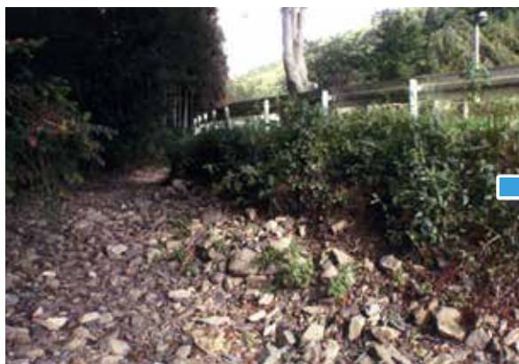
吉浜沢川復旧前(北上地区・十三浜)
