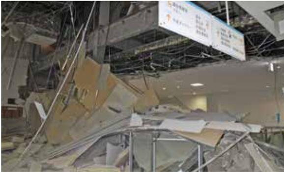
3月11日午後2時46分に地震が発生。約3分にわたる揺れで本庁舎6階では天井が崩落した。
