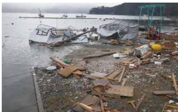
地盤沈下で満潮時は海に沈み込む漁港。（雄勝地区・水浜漁港）
