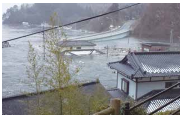
津波に襲われる新相川橋。(写真中央上)
