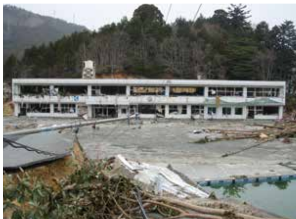
牡鹿半島東部の鯨浦湾に面する地域にあった谷川小学校。津波により2階の窓も破壊された。(牡鹿地区・大谷川浜)
