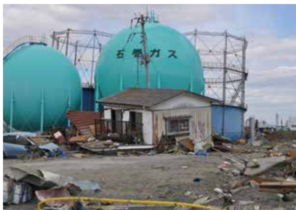
津波の直撃を受け、供給不能となった都市ガス製造工場。(石巻地区・湊東)
