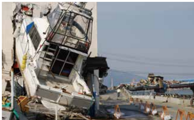
至る所で流された船が建物に衝突したり、打ち上げられたりしていた。(中央)
