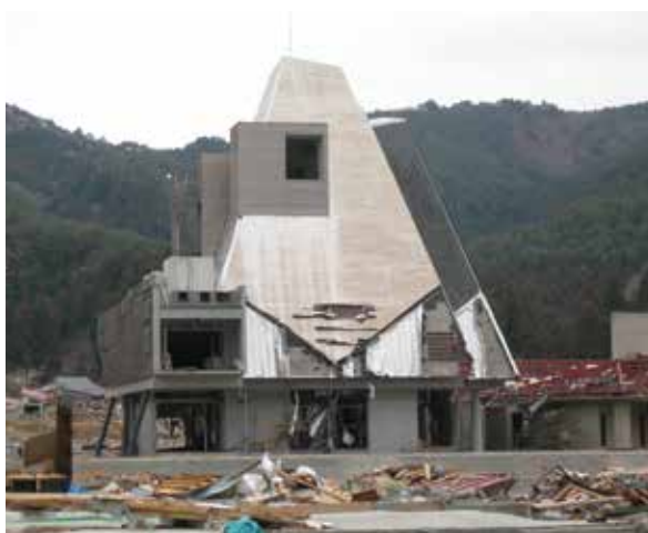
雄勝硯伝統産業会館は一部5階建てであるが、そのうち4階までが津波により被害を受け、収蔵物のほとんどが流された。(雄勝地区・雄勝)
