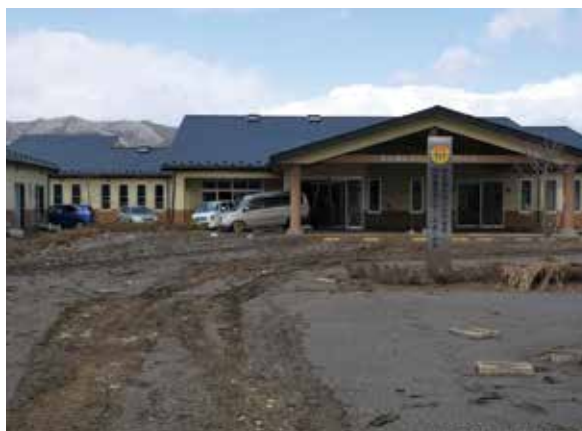
北上川河口から約3km上流にあった特別養護老人ホームきたかみは津波で浸水した。(北上地区・橋浦)
