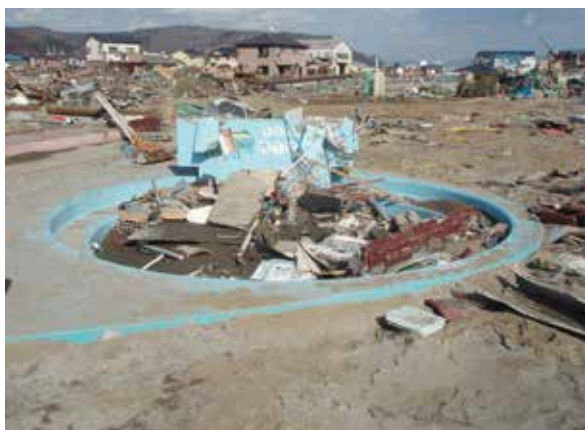
一部を残し、津波で流失した門脇保育所。(石巻地区・門脇町)
