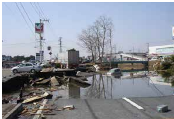
道路が陥没し通行不可能となった国道398号。(石巻地区・中浦)
