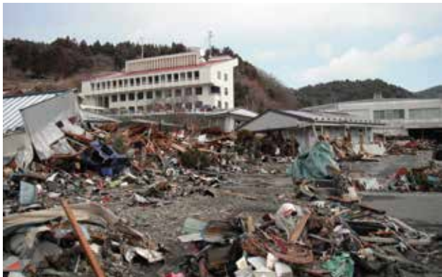
牡鹿地区の各集落でも、低平地の木造の建物のほとんどが全壊となった。(鮎川浜)
