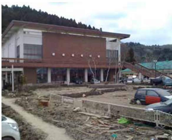
石巻市民会館は、震災前より老朽化などの理由で取り壊しが決定していたが、津波で被災して以降は使用禁止となり、その後解体された。(石巻地区・不動町)
