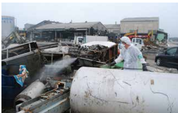
取り残された冷凍物などが腐敗し、害虫が発生。衛生状態も悪化し、消毒作業が行われた。(石巻地区・魚町)
