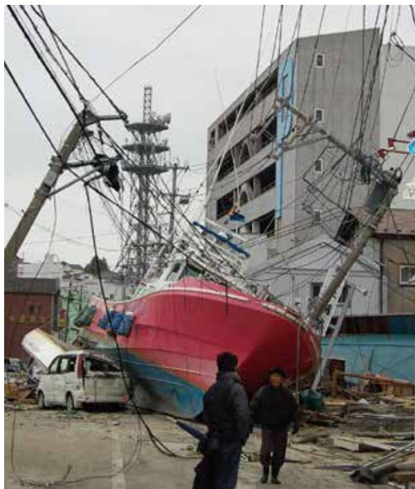
電柱、電線への被害で復旧作業は困難を極めた。(石巻地区・中央)
