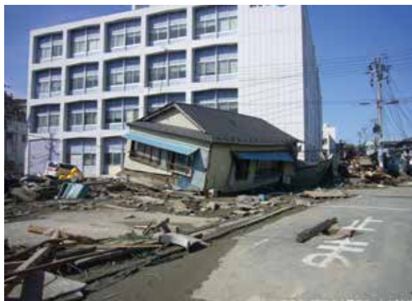
NTT東日本石巻門脇ビルは電力設備が津波で浸水したが、通信設備は上位階にあったため浸水を免れた。(石巻地区・門脇町)
