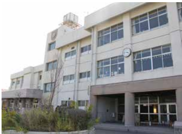
解体前の女子商業高校校舎。津波で1階部分のガラスがなくなっている。1957（昭和32）年に開校した渡波家政専修学校以来、55年間渡波地域に立地したが、閉校を余儀なくされた。
