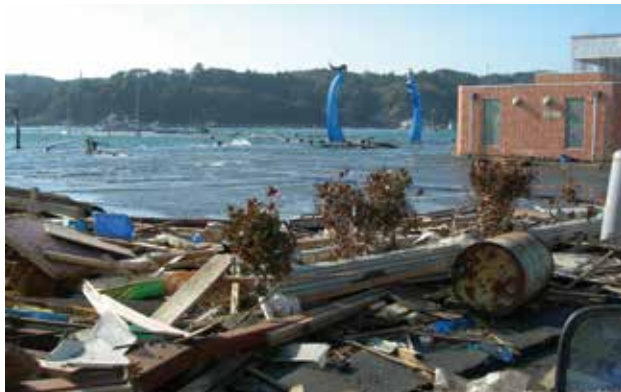
地盤沈下で岸壁が海水面より低くなった鮎川港。(鮎川浜)
