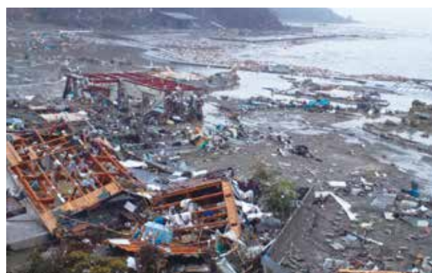
一時的に波が引いた後の様子。一部の鉄骨造を除き、ほとんどの建物が流失。
