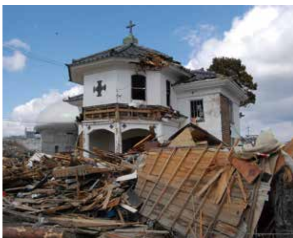
津波の直撃を受けた旧石巻ハリストス正教会教会堂。壁の一部がはがれ落ち、柱も斜めになり建物もゆがんだ状態となったが、倒壊は免れた。(石巻地区・中瀬)
