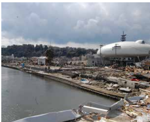
石ノ森萬画館は津波で浸水。建物は残ったものの、1階にあった物のほとんどはガラスを突き破り流出した。(石巻地区・中瀬)
