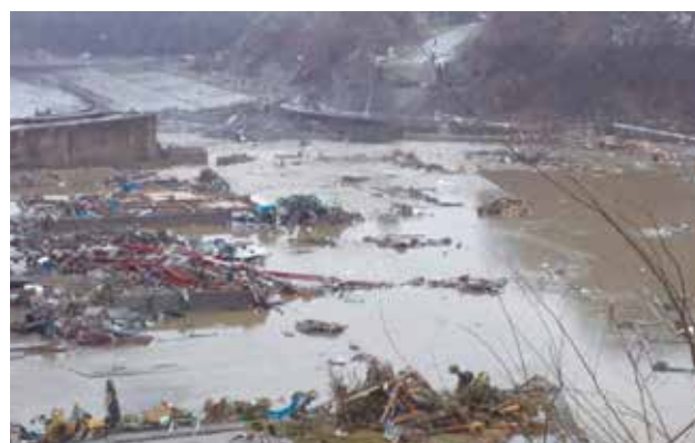
土台部分のみが残り、津波により橋が流されたことが分かる。
