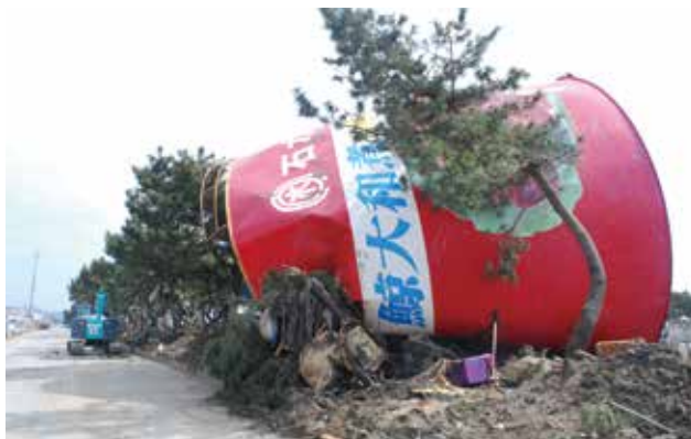
缶詰工場から県道の中央分離帯まで約300m流されたタンク。(石巻地区・魚町)
