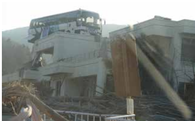
流されたバスが雄勝公民館屋上に取り残されている。この光景は雄勝地区の被災の象徴となった。(雄勝)
