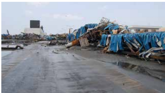
津波により上屋設備が全壊した石巻売場。(石巻地区・魚町)
