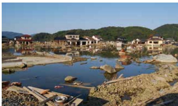
発災から半年が過ぎた被災住宅地。全壊した家屋が残っており、地盤沈下と排水不良で地域全体が水没している。(長面)
