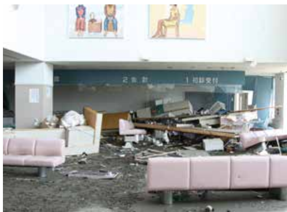
1階ロビーは津波が侵入し、待合室の腰掛やカウンターなどが破壊された。
