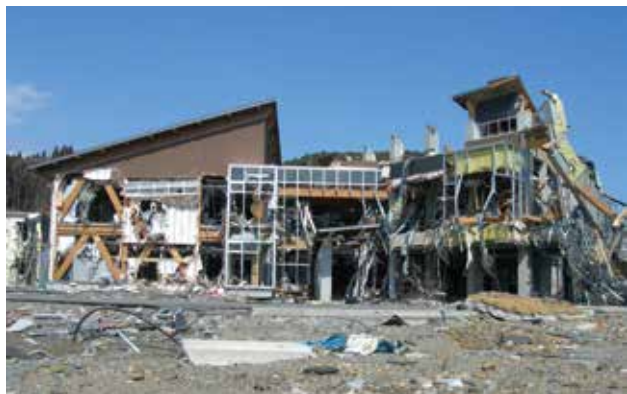
北上総合支所は避難所となっていたが、想定を超える津波により全壊した。(十三浜)
