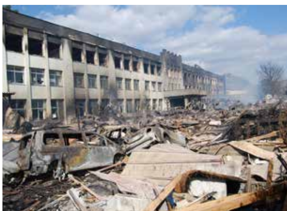
発災翌日の門脇小学校校舎。津波と火災の被害を受けた。校庭では車、木材などが積み重なり、煙が立ち上っている。(石巻地区・門脇町)
