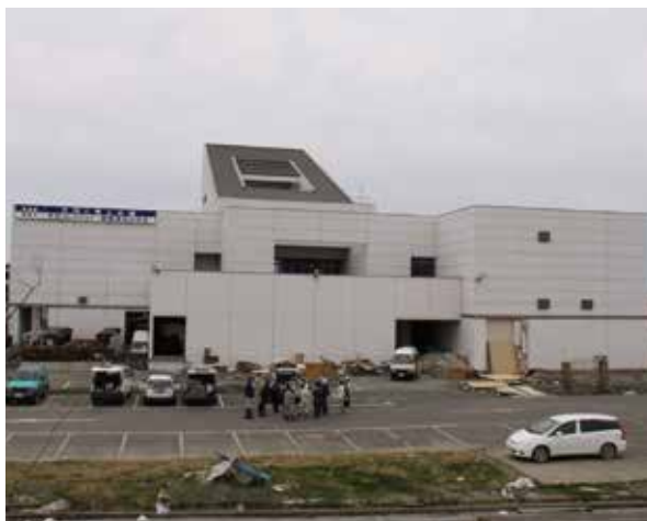
旧北上川の河口付近にあった石巻文化センターは津波が直撃した。特に1階は、第1収蔵庫を除き壊滅的な被害を受けた。(石巻地区・南浜町)
