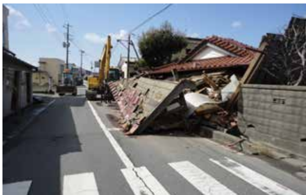
地震により倒壊した家屋が道路の片側をふさいだ。(中津山)
