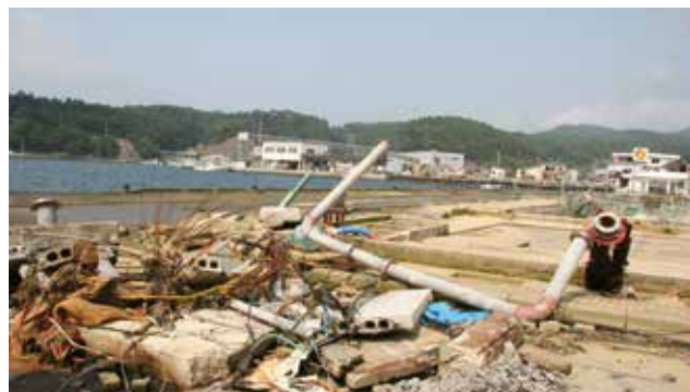
牡鹿売場があった鮎川港も壊滅状態。(牡鹿地区・鮎川浜)
