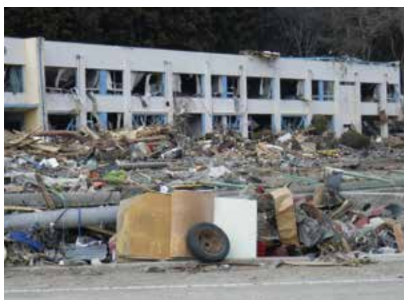
雄勝湾奥部に位置する雄勝小学校は、屋上の高さまで津波が押し寄せた。建物は残っているものの、ほとんどの窓ガラスは割れている。(雄勝地区・上雄勝)
