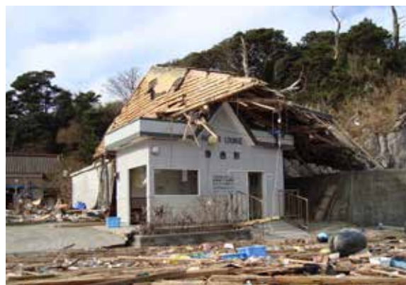
流されてきた屋根が乗り上がった網地島のフェリー待合所。(牡鹿地区・網地浜)
