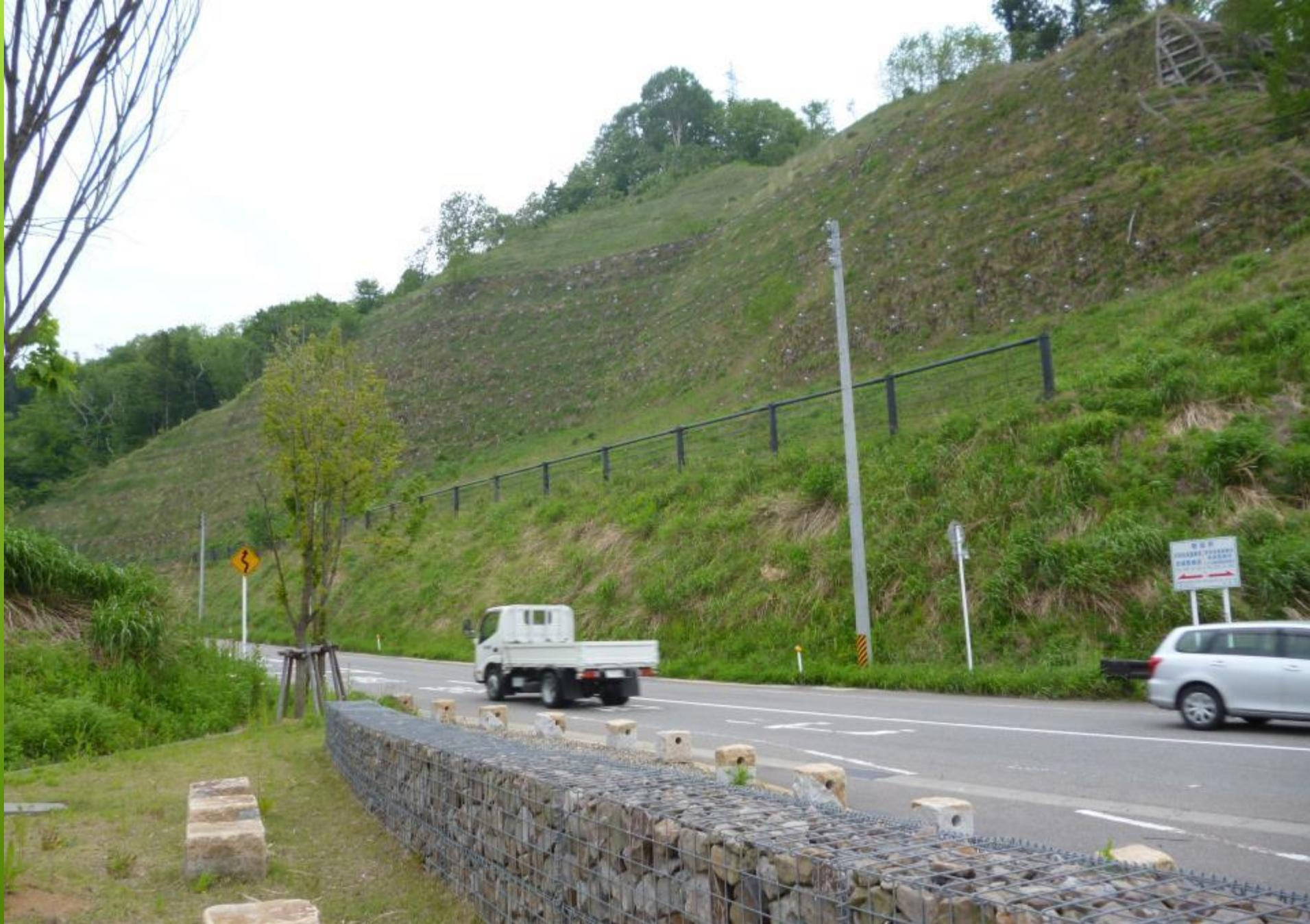
道路部分は、土砂を除き法面を補強する等再整備を行う。
