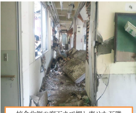
校舎北側の廊下まで押し寄せた瓦礫
