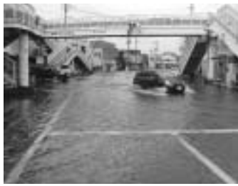
昨年10月の道路冠水状況
