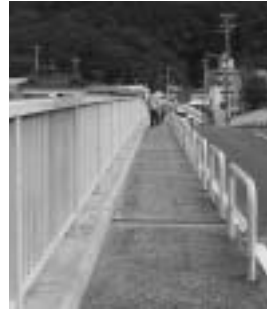
内海橋の歩道
