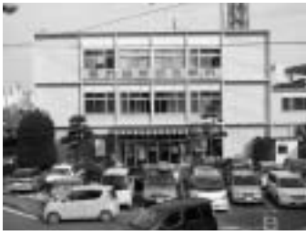
石巻市役所本庁舎
