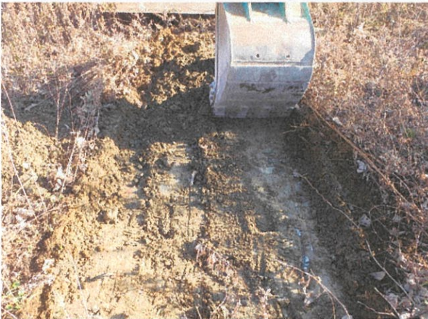
トレンチ1 掘削状況(表土剥ぎ)
