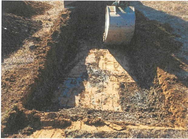
トレンチ4 掘削開始
