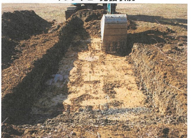
トレンチ3 掘削状況(地山検出)
