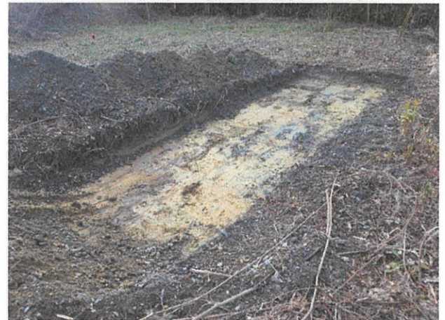
トレンチ9 掘削状況(地山検出)
