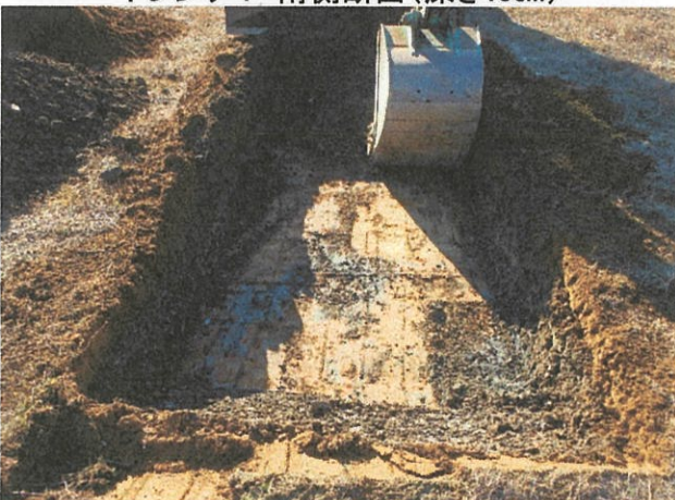
トレンチ5 掘削開始
