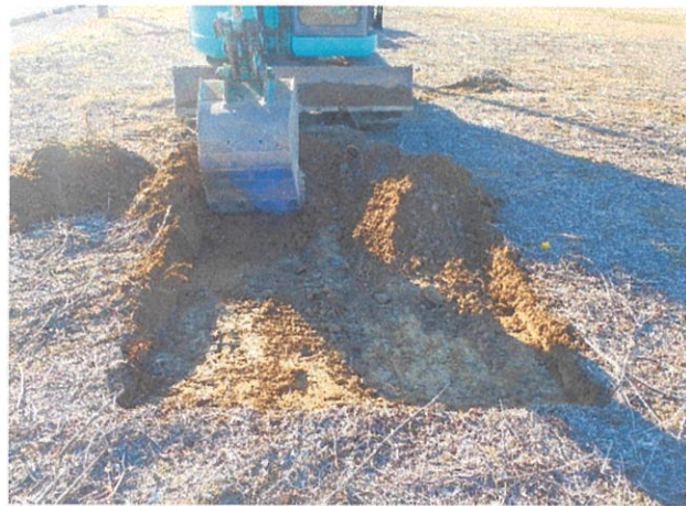
トレンチ6 掘削開始
