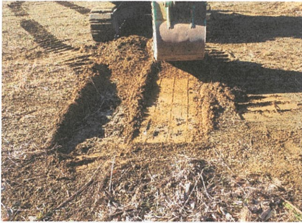
トレンチ2 掘削開始
