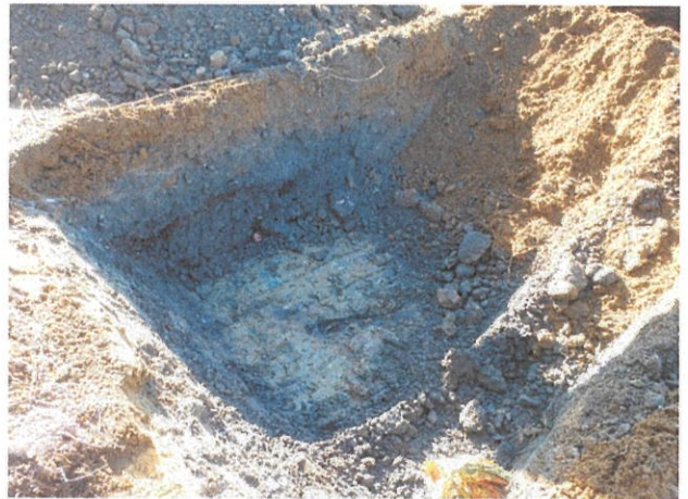
トレンチ2 掘削状況(地山検出)
