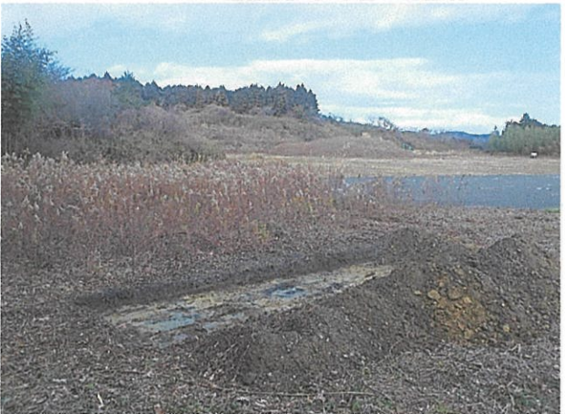
トレンチ9 掘削状況
