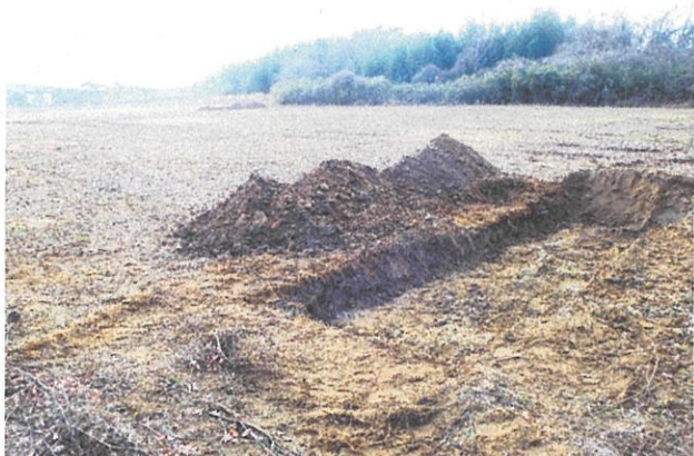
トレンチ7 掘削状況(北東→南西)
