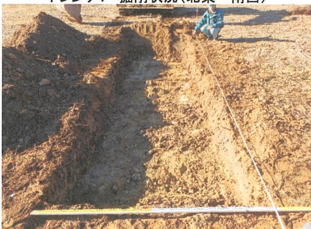
トレンチ7 掘削状況(地山検出)
