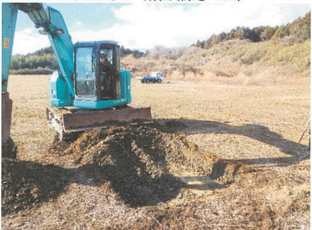
トレンチ3 掘削開始
