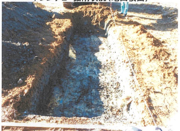
トレンチ2 完掘状況
