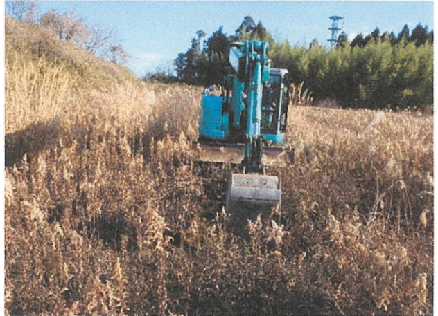
トレンチ1 掘削開始
