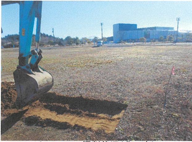
トレンチ8 掘削状況(北→南)
