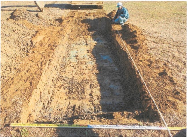
トレンチ8 掘削状況(地山検出)
