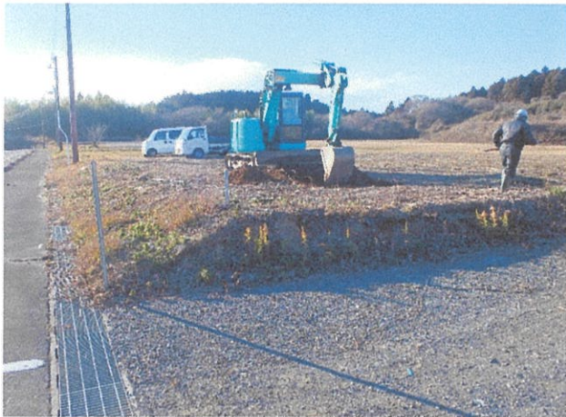
トレンチ6 掘削開始
