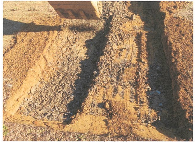
トレンチ8 掘削状況
