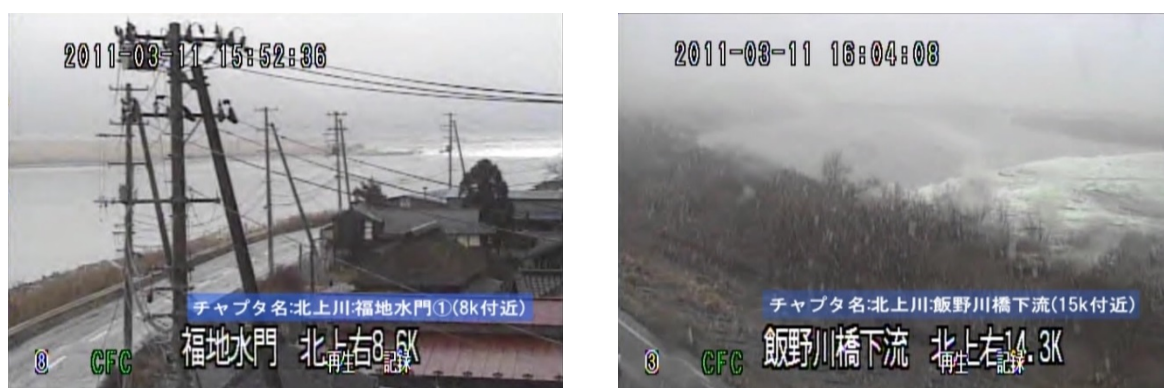
図3：福地水門、飯野川上流の河川監視カメラの映像から
