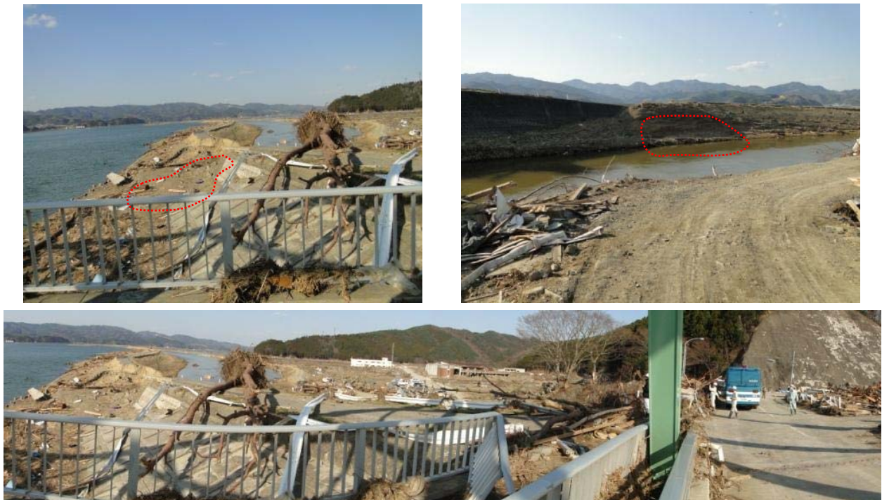
図 11：新北上大橋下流部堤防の損壊（右：川面から、左：川裏から、下：川面パノラマ撮影）
