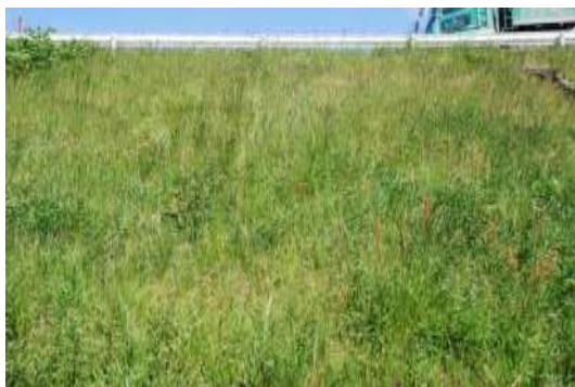
堤防法面上部
