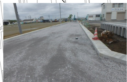
③[上水道整備完了]
