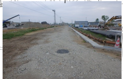
②[污水管築造工完了]
