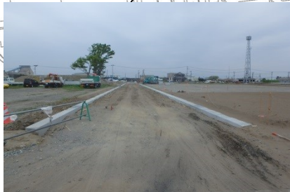
①[側溝設置工完了]
