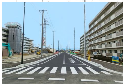
[道路供用状況]
