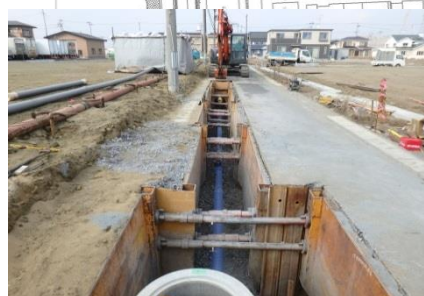
[污水管布設状況]
