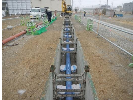
污水管布設状況
