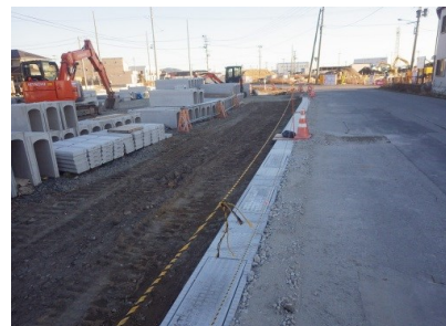
▲ 側溝敷設状況
