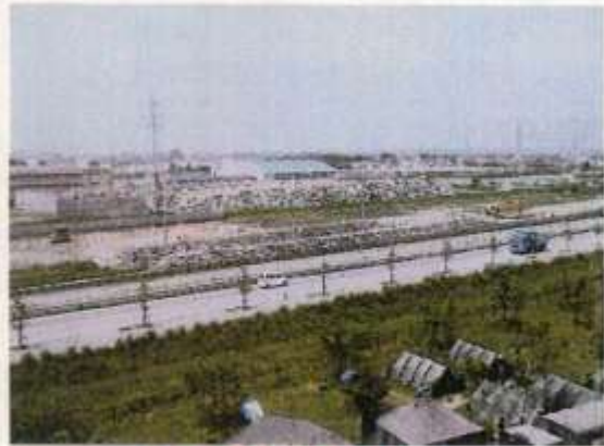
1次仮置き場全体写真
