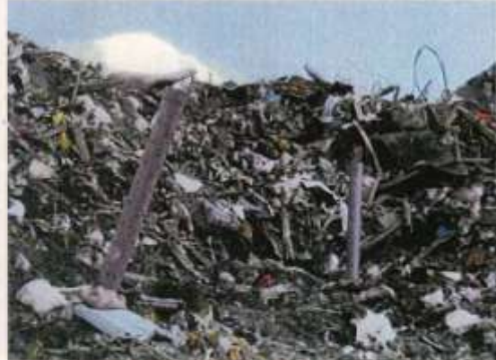
自然発火防止の熱放出用パイプ
