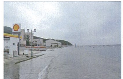
1m以上の地盤沈下（鮎川港）
