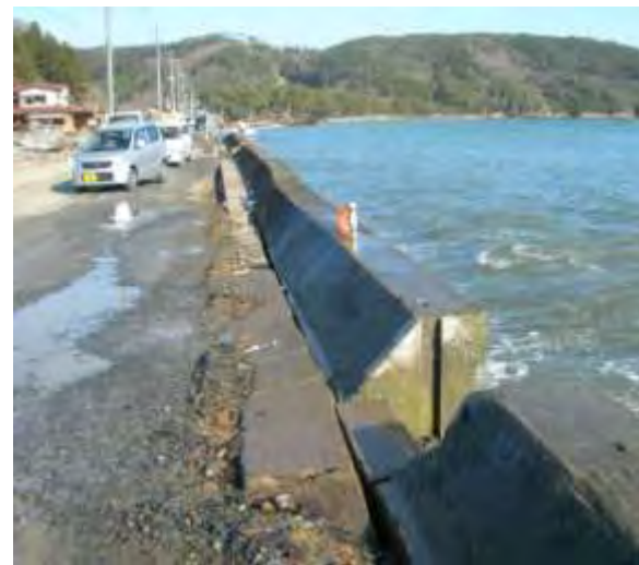
▲地盤沈下と防潮堤の被災により道路に波しぶきがかかり通行が危険。牡鹿地区十八成海水浴場付近の県道(4月16日撮影)
