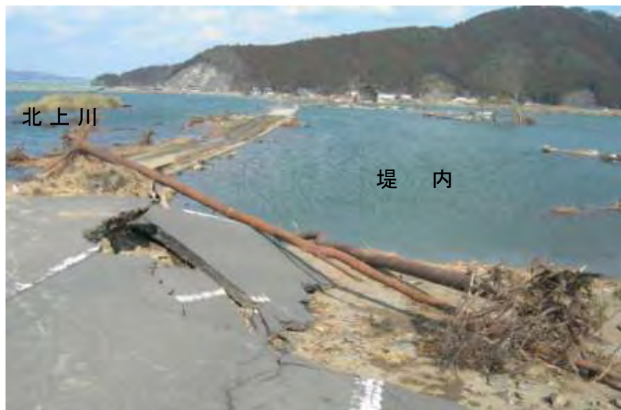
津波により堤防が破堤し、堤内が一面の海と化した間垣地区 3月19日撮影
