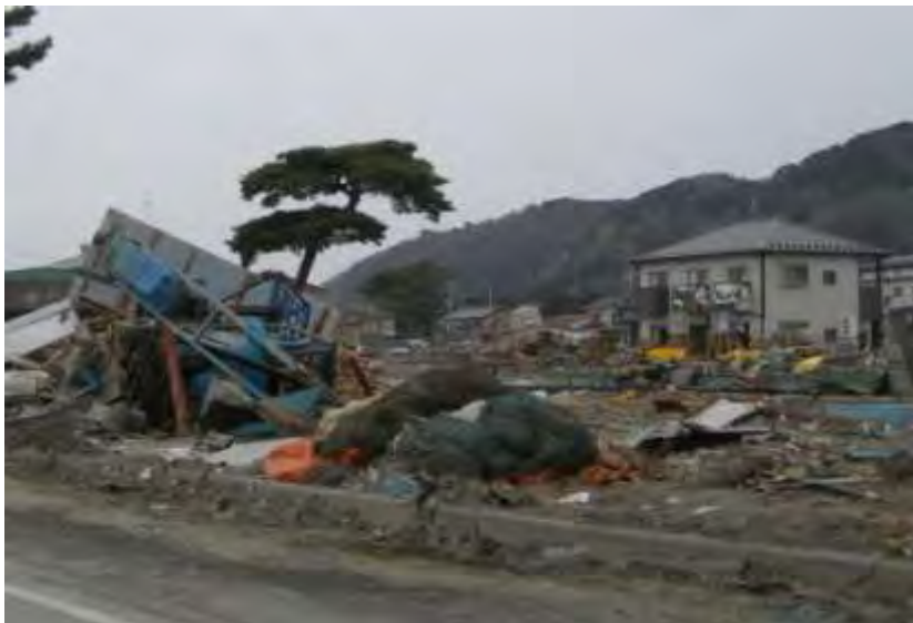
▲石巻漁港背後地の臨港道路背後の被災状況(3月25日撮影)
