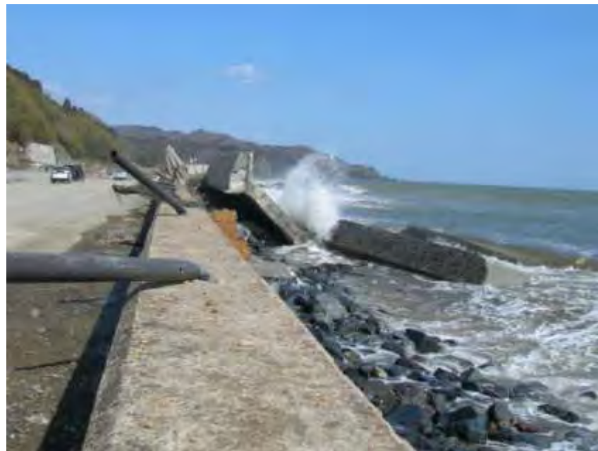
立神海岸の防波堤が津波により被災(3月19日撮影)
