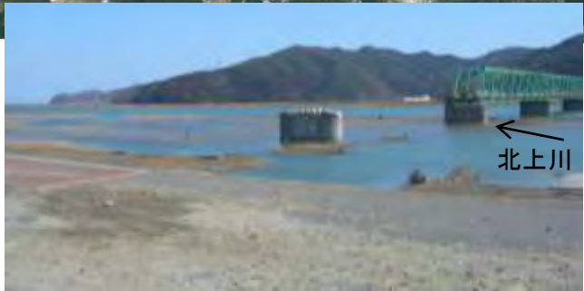
津波によって新北上大橋の左岸側2経間が流出 (3月19日撮影)
