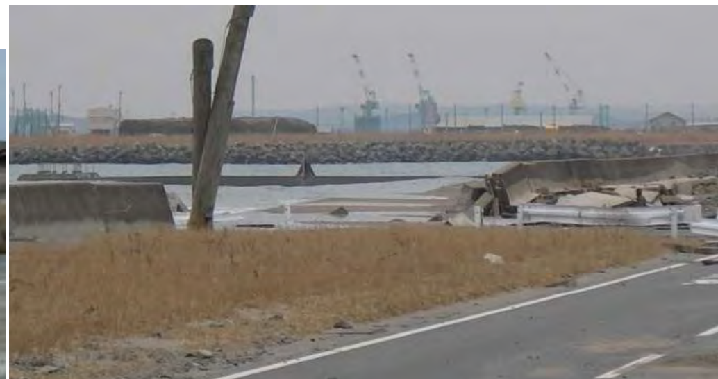
▲被災した雲雀野海岸堤防の状況(3月21日撮影)
