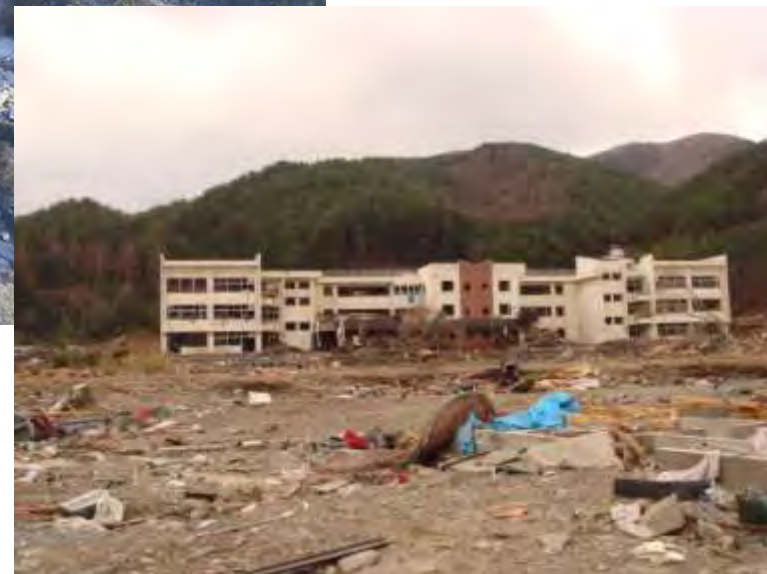
▲雄勝中学校の被災状況(3月22日撮影)
