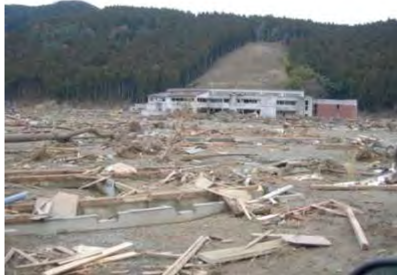
大川小学校付近の被災状況(3月25日撮影)
