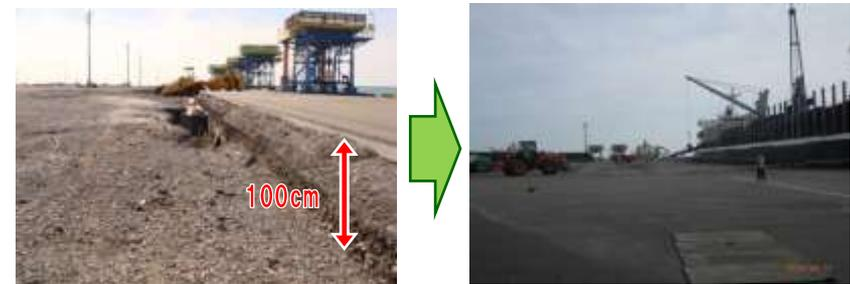
石巻港雲雀野埠頭 地盤沈下の復旧状況
