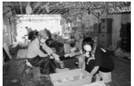
▲ボランティアの方々による修復作業の様子
