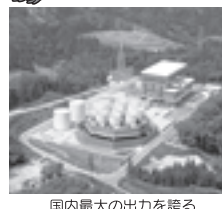
国内最大の出力を誇る柳津西山地熱発電所
