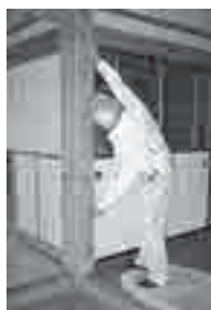
住宅診断の様子
