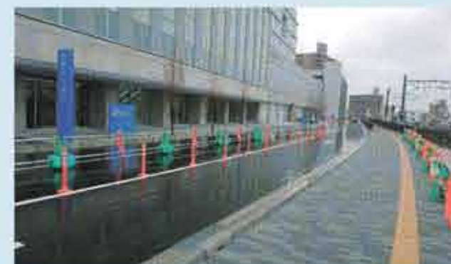
▲完成写真 (病院北側)
