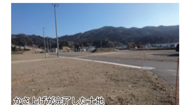
かさ上げを行い、道路を整備
