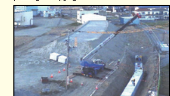
▲湊中央線道路築造工事の様子
