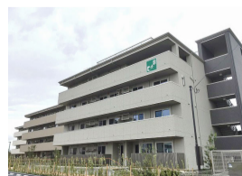
市営大門町復興住宅 1号棟、2号棟
