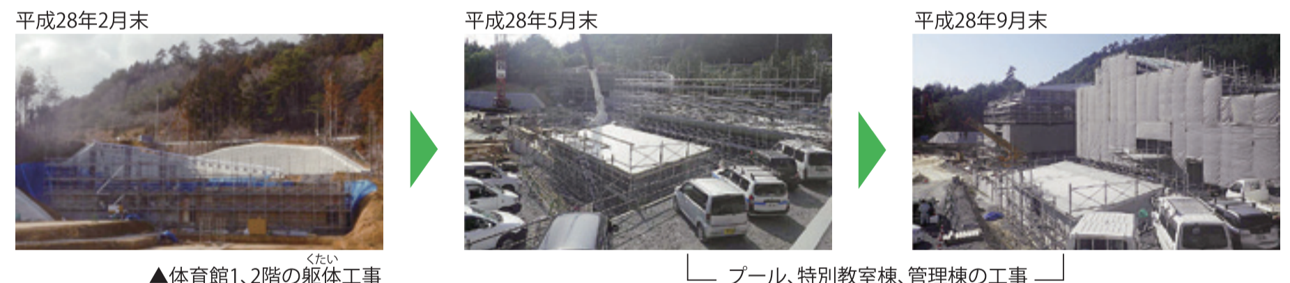
▲体育館1、2階の躯体工事
