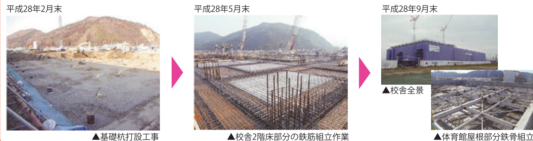
▲基礎杭打設工事
