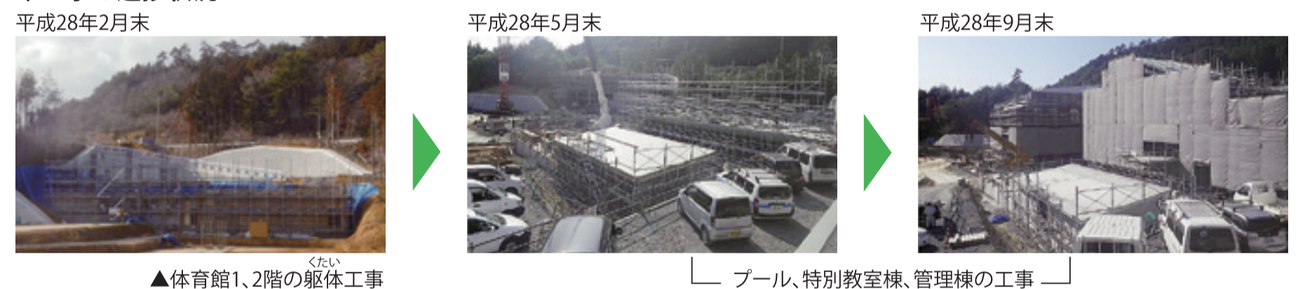
▲体育館1、2階の躯体工事
