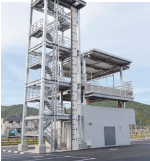
▲県内の消防署で最も高い21mの訓練塔
