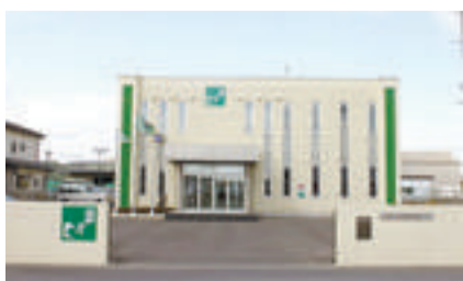
協業組合石巻廃棄物処理センター事務所
