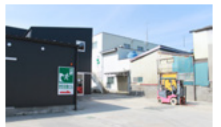
湊水産株式会社 冷蔵・倉庫棟
