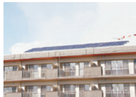
太陽光パネル
