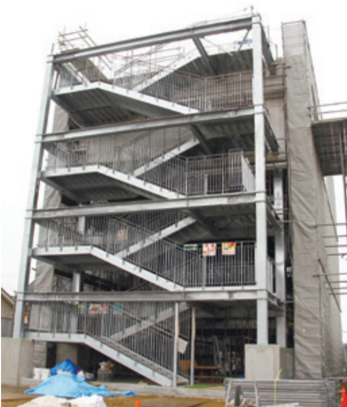
▲高さ13.4メートルの高床式住居です
