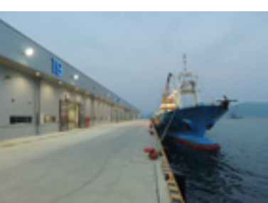
東棟完成写真
