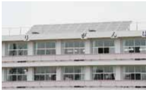
▲太陽光パネル (9月撮影)
