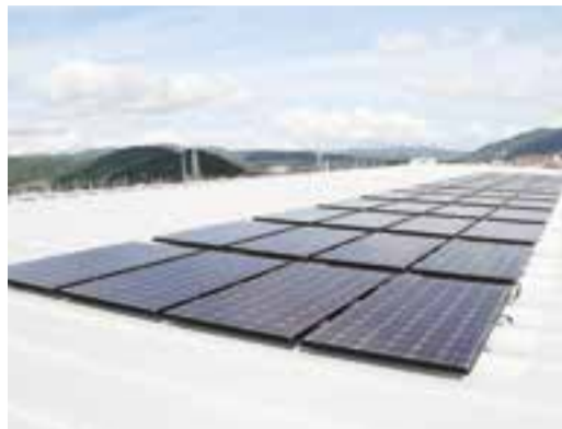
▲太陽光パネル (9月撮影)
