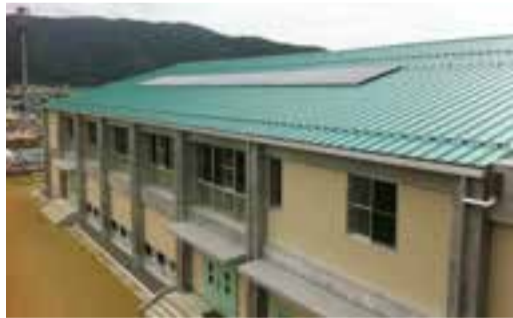
▲太陽光パネル (9月撮影)
