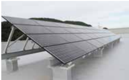
▲太陽光パネル (9月撮影)
