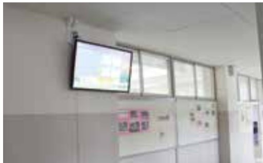
▲モニタ設備 (9月撮影)
