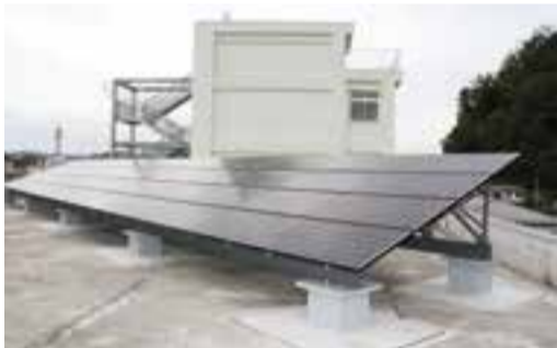
▲太陽光パネル (9月撮影)
