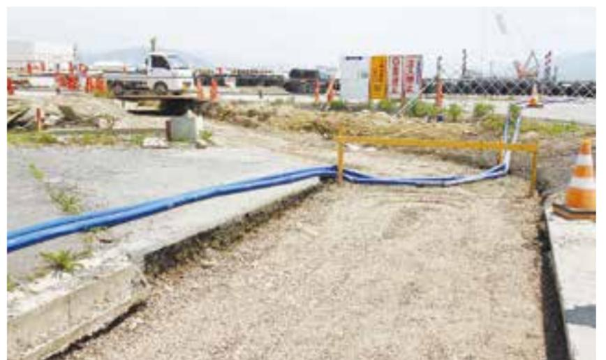
海水は、地下に埋設されたパイプを通り、荷捌き施設へ送られます。
