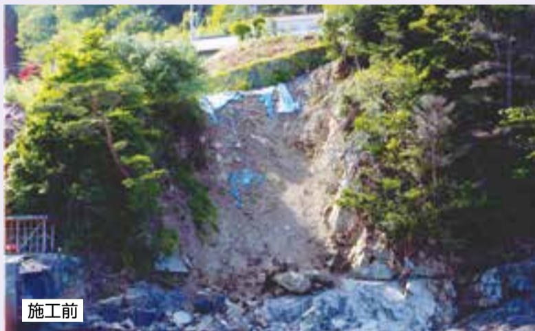
熊沢2号線道路災害 復旧工事 ⑦
