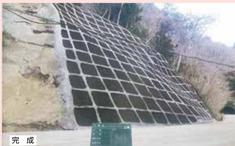
水浜波板線災害 復旧工事 ⑧
