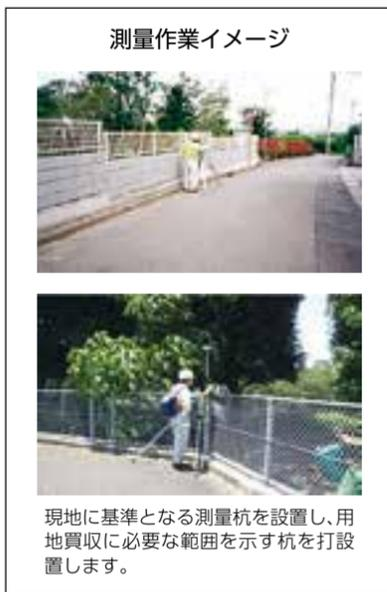
現地に基準となる測量杭を設置し、用地買収に必要な範囲を示す杭を打設置します。
