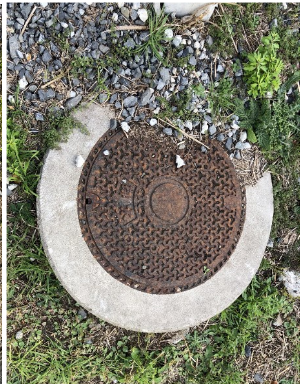
撮影⑪存置マンホール②
