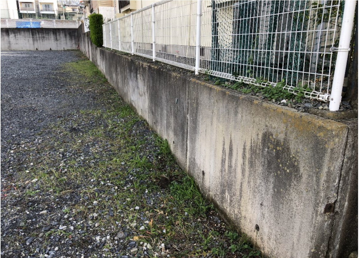
撮影⑫南側隣地擁壁
