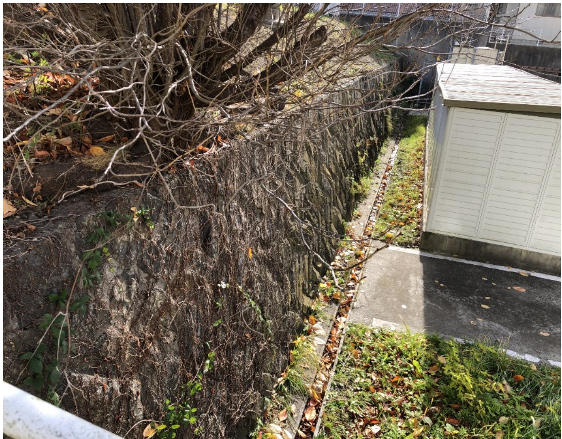
撮影⑬西側隣地擁壁
